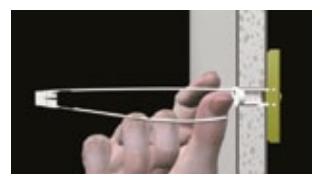
• Montagestreifen am Ring abbrechen
