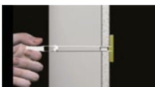
• Anker ins Bohrloch einführen
