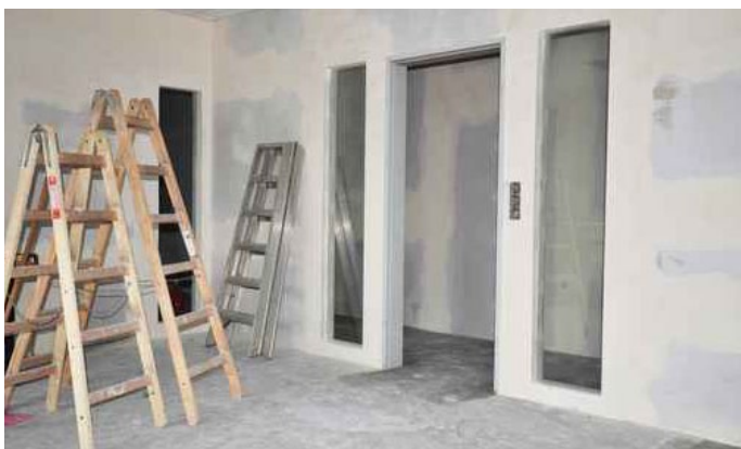
Neubau mit Leichtbauwänden und Hohlräumen
