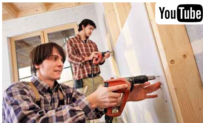
Ausbau und Renovierung mit Hohlraumwänden
